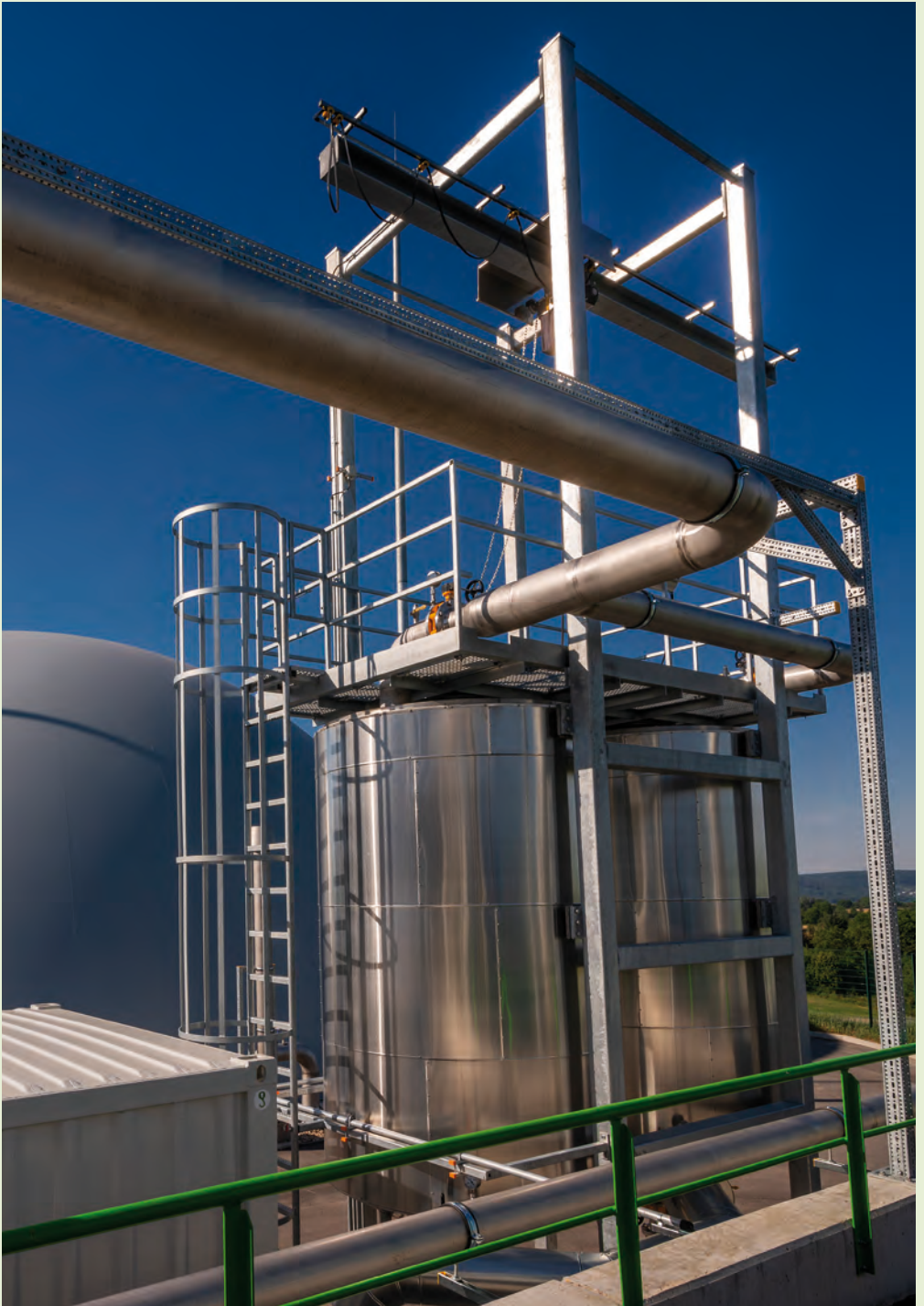
Feinentschwefelung mittels Aktivkohlefilter
